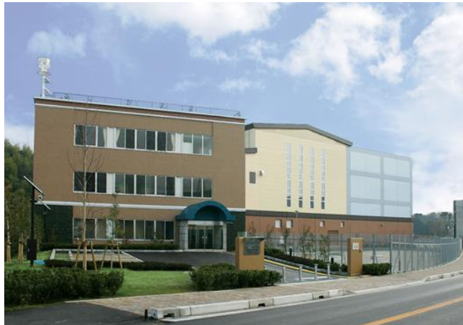
写真1 リサイクルプラザ全景
