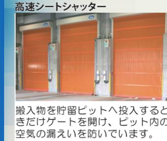
搬入物を貯留ピットへ投入するときだけゲートを開け、ピット内の空気の漏えいを防いでいます。
